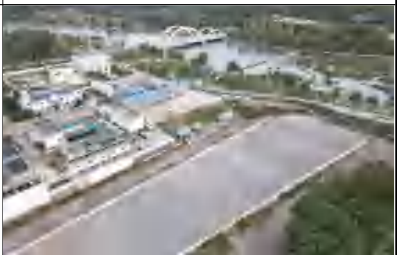
线路跨越沁河处
